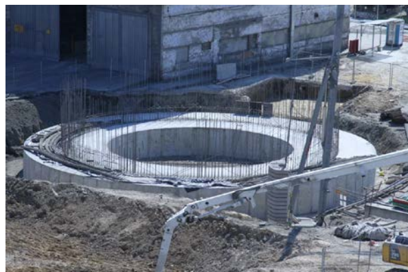
Фигура 1: Фундаментен стоманобетонен пръстен
